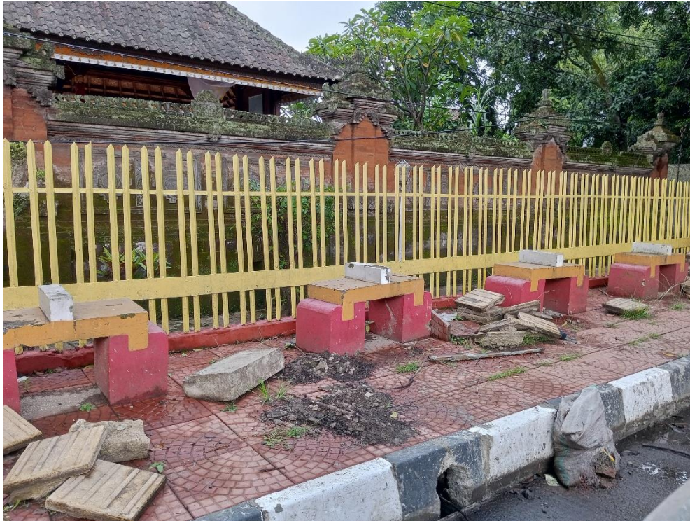
Gambar 21 Lokasi Pemeriksaan Jalan Station
