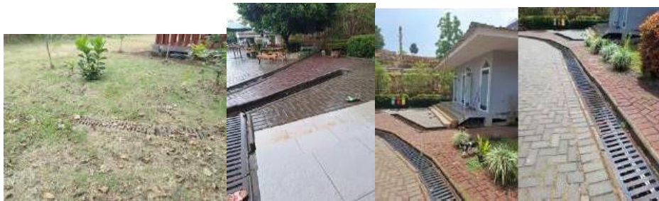
Gambar 6.6.63 Kondisi selokan pada taman ekowisata
